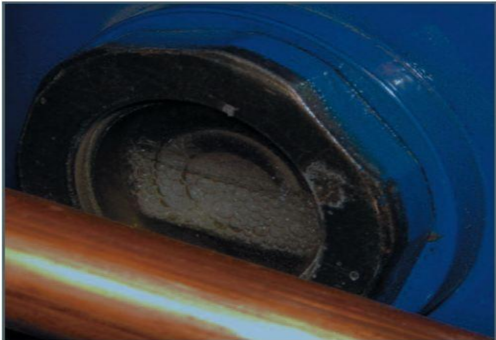
کف کردن روغن را می توان از طریق شیشه روئیت مشاهده کرد ، این نشانه خوبی از حضور مایع مبرد در روغن کمپرسور است
